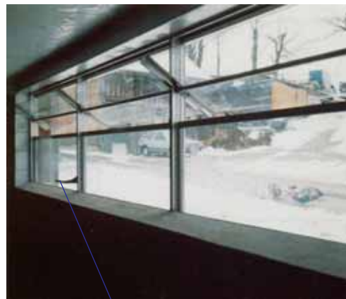
Gruppen von 3 Fenster im Rahmen eingebaut
