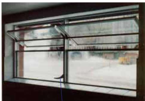
Gruppe von 2 Fenster im Rahmen eingebaut
