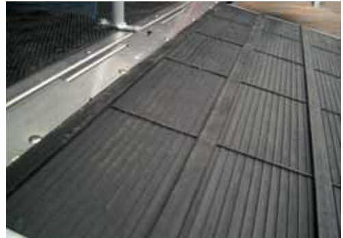
Laderampe mit Kautschukteppich
